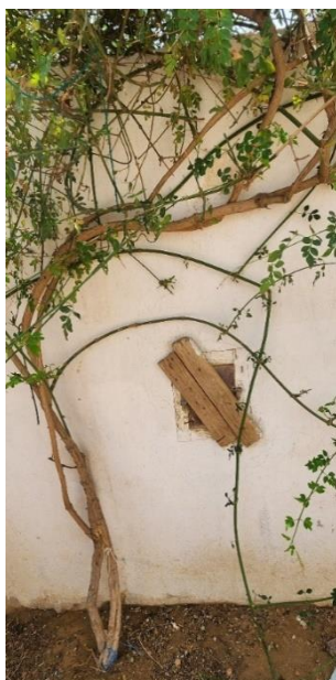
La fenêtre dans la clôture à travers laquelle Wansa a assuré son petit commerce, illustration de juin 2025
